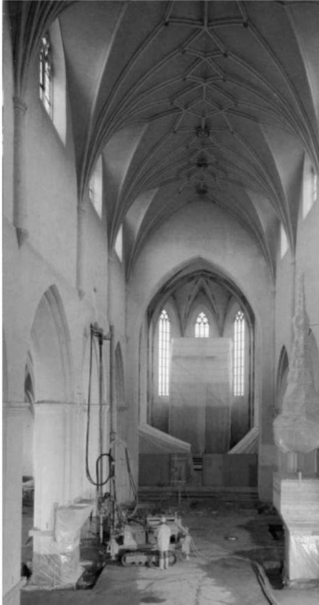
*Sottofondazione con jet grouting di una chiesa (da Fiorotto, 2000).*
